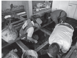
床下の泥出しの様子
